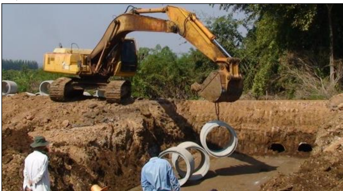
รูปที่ ๒-๑๐ การใช้รถชุดยกท่อในงานขุดวางท่อระบายน้ำ
