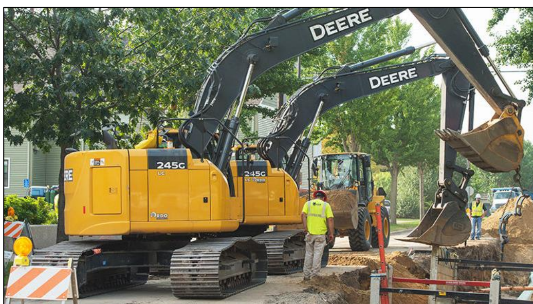
รูปที่ ๑-๑๑ รถขุดไฮดรอลิกขนาดน้ำหนัก ๑๐ – ๓๐ ตัน
