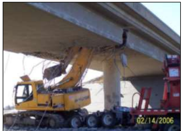
รูปที่ ๔-๕๖ อุบัติเหตุที่เกิดจากการบรรทุกเครื่องจักรผ่านเส้นทางที่มีความสูงจำกัด
