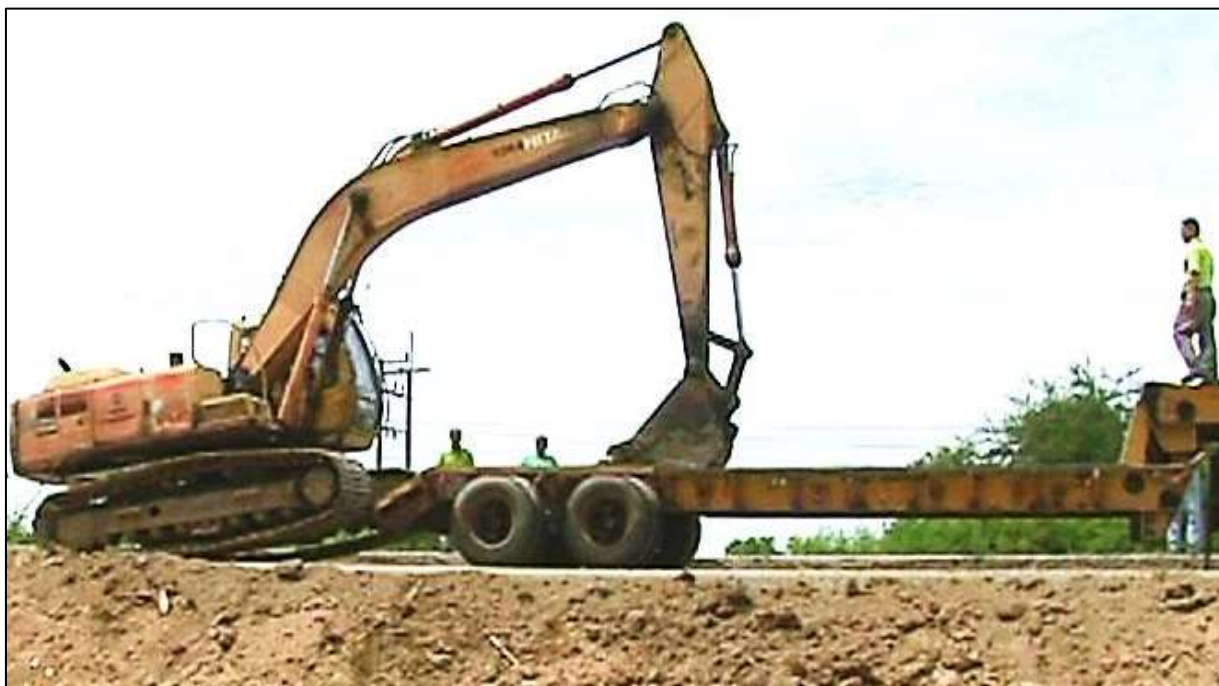
รูปที่ ๔-๔๙ การขึ้นลงรถบรรทุกเครื่องจักรกลของรถชุด
