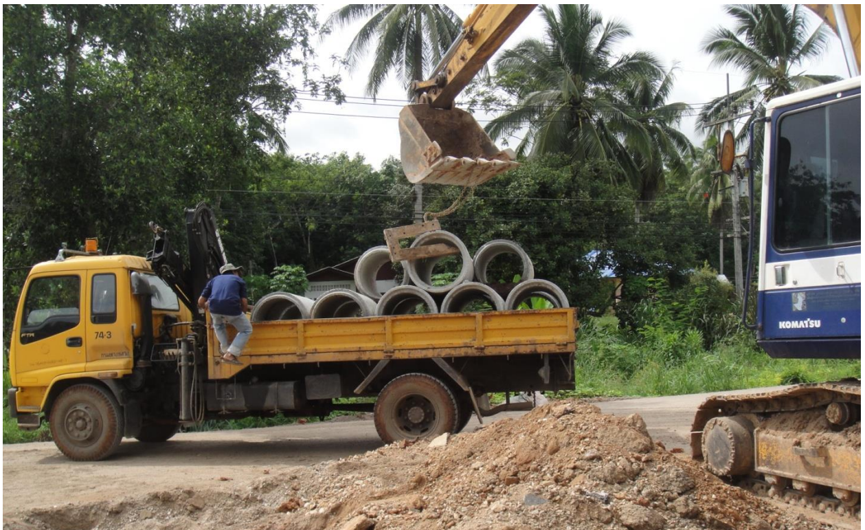
รูปที่ ๒-๑๕ การใช้รถชุดในงานยกวัสดุในงานก่อสร้างทาง
