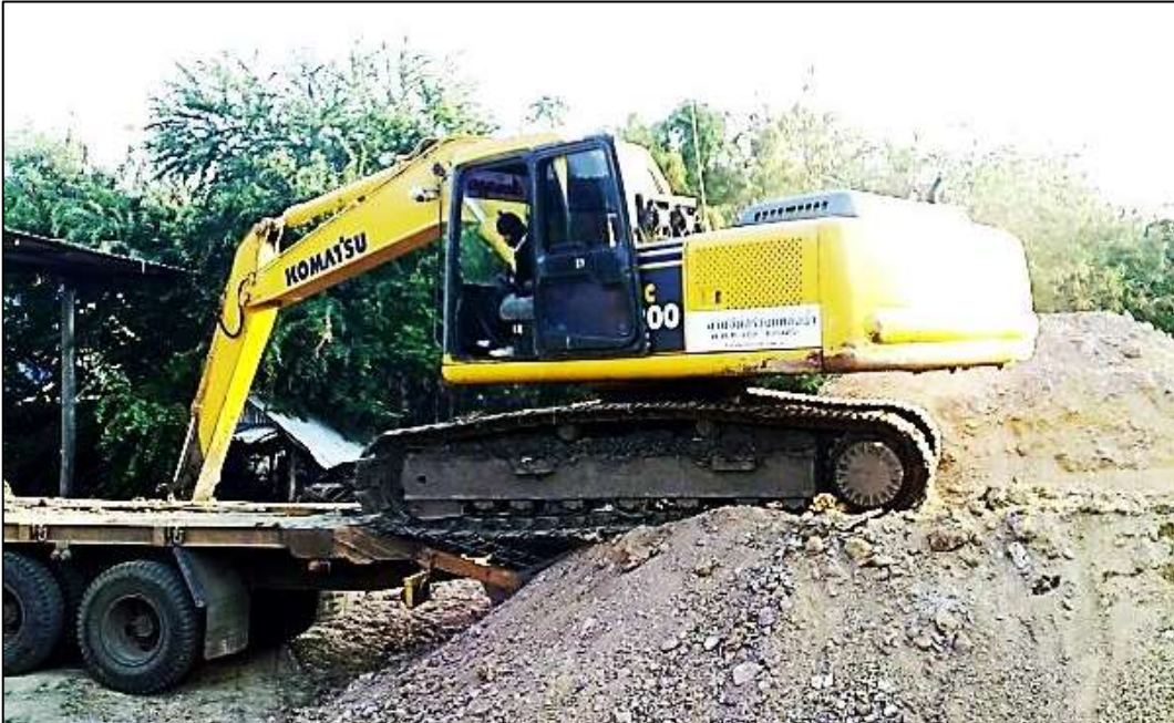
รูปที่ ๔-๔๗ การขึ้นท้ายรถบรรทุกโดยใช้เนินดิน
