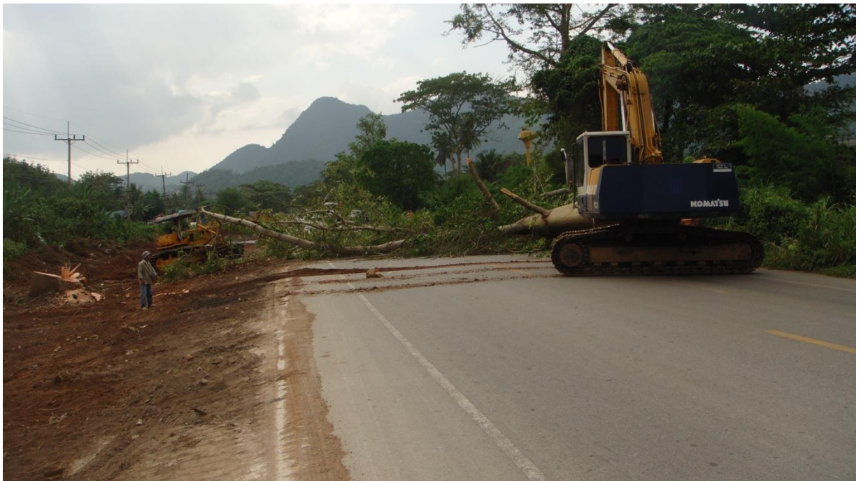
รูปที่ ๒-๒ การทำงานของรถชุดในงานถางป่าชุดต่อ
