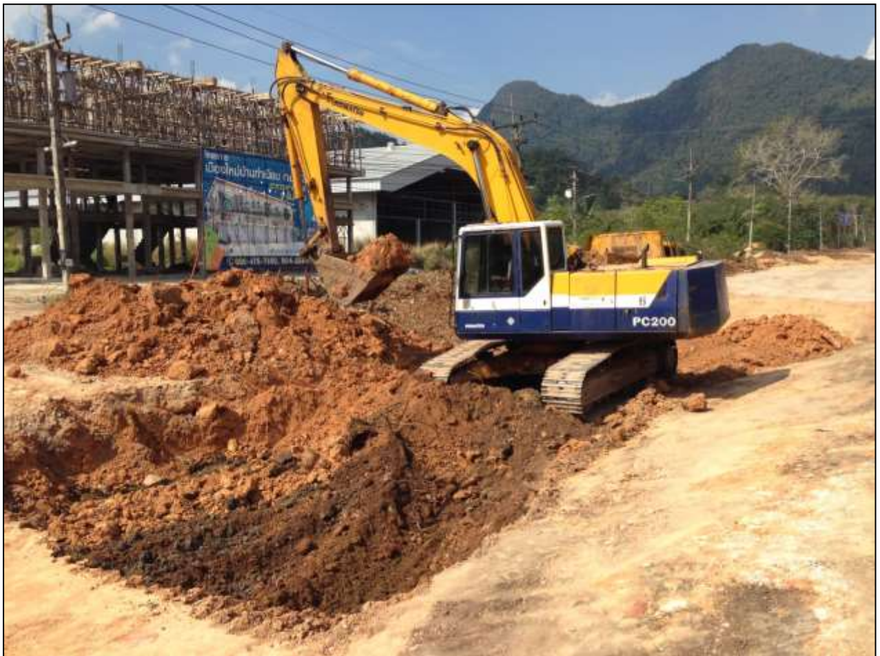
รูปที่ ๔-๒๖ การปรับพื้นที่โดยใช้บั้ง
