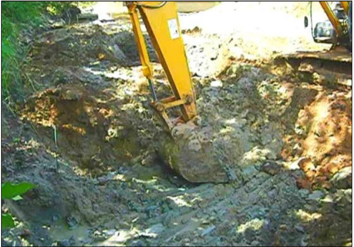
รูปที่ ๒-๔ การทำงานของรถขุดในงานไล่ดินเลน ขั้นตอนการขุดตักดินเลนออกไป
