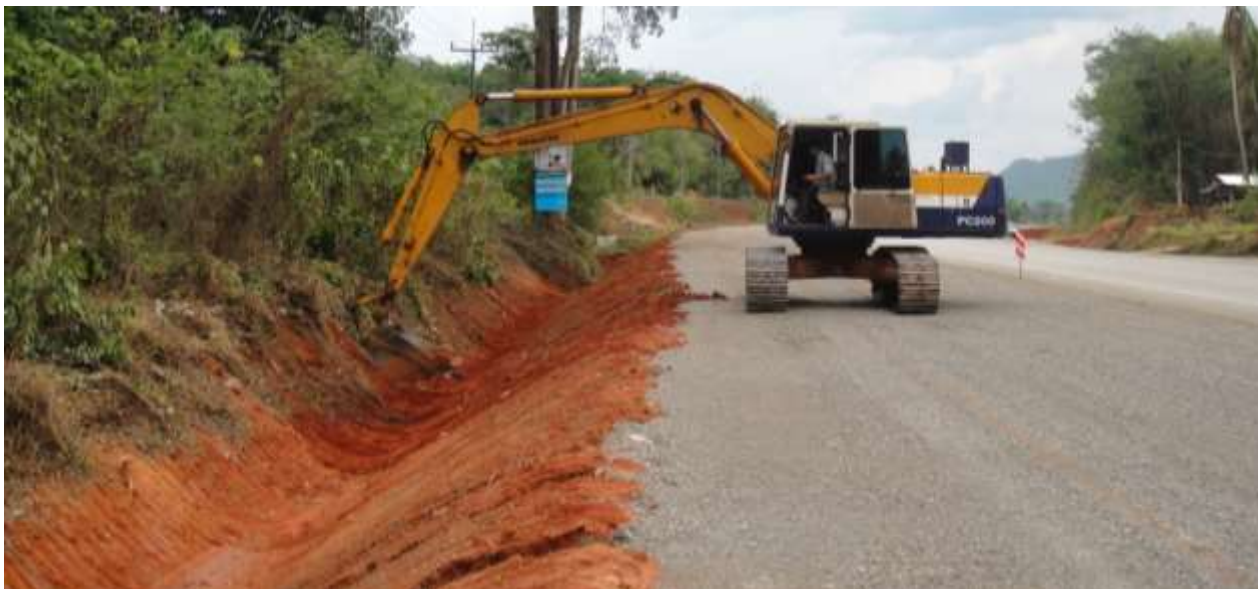
รูปที่ ๔-๓๑ งานแต่งลาดคันทาง
