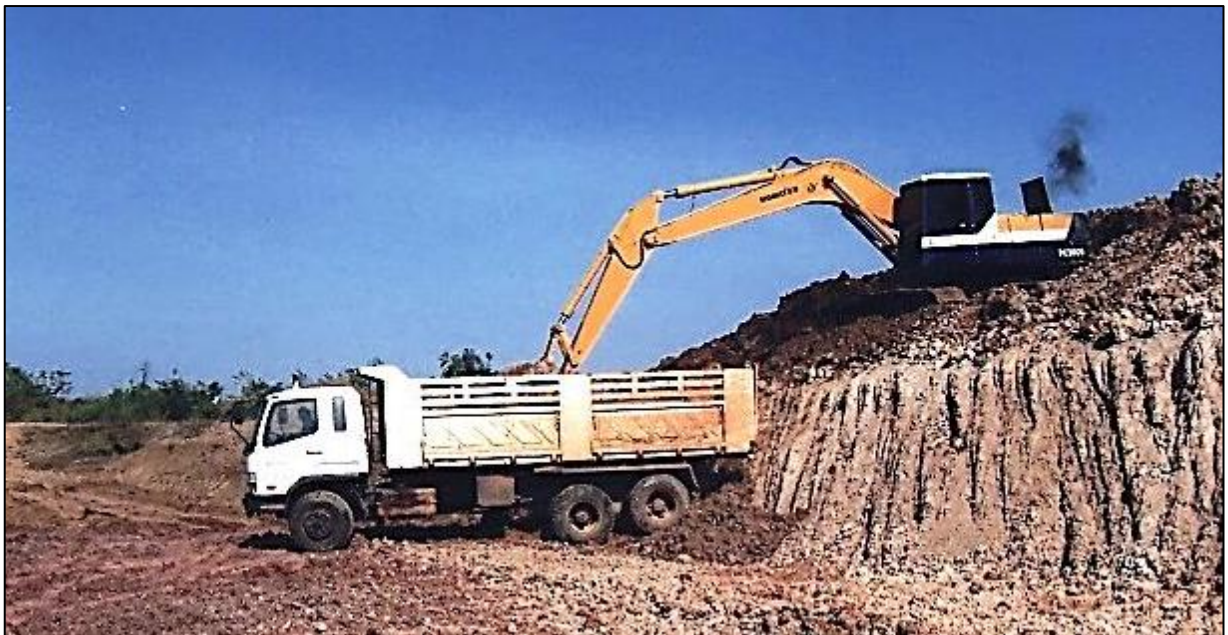
รูปที่ ๒-๘ การตักวัสดุจากบ่อขุด
