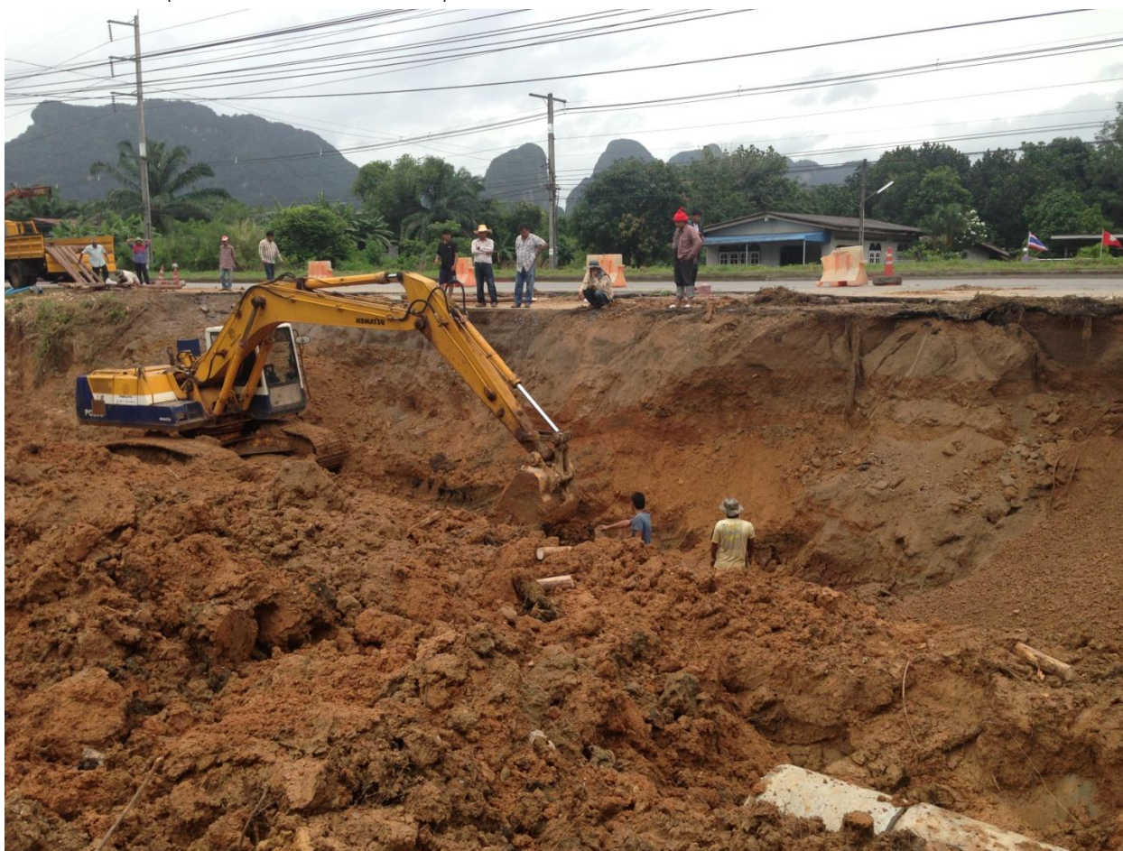
รูปที่ ๒-๑๓ การแต่งสโลปด้านข้าง
