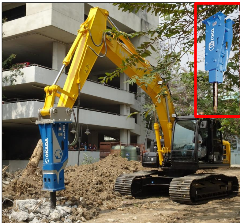
รูปที่ ๓-๓๑ รถขุดติดตั้งหัวกระแทก
