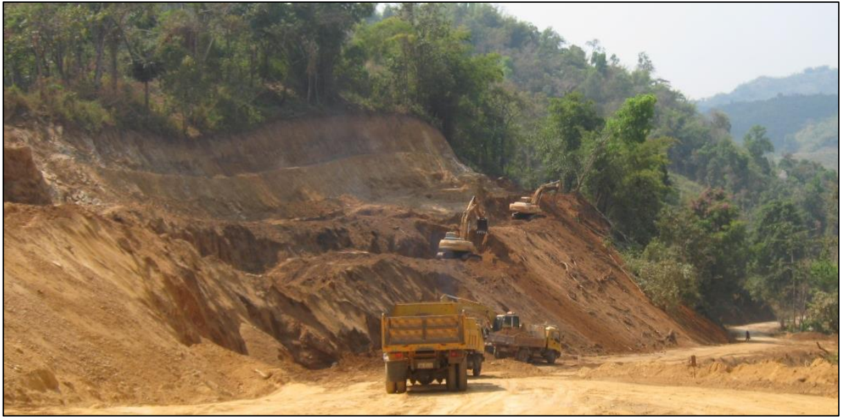
รูปที่ ๒-๑๔ การใช้รถชุดในการตัดลาดคันทางเชิงเขา
