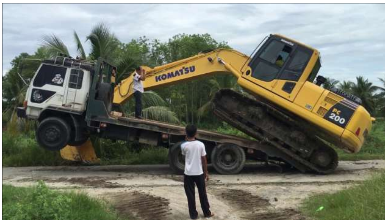
รูปที่ ๔-๕๗ อันตรายที่เกิดจากรถบรรทุกกระดกขึ้นเมื่อรับน้ำหนักของรถขุด
