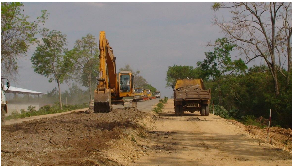
รูปที่ ๒-๖ การทำงานของรถขุดในงานรื้อโครงสร้างคันทางเดิมเพื่อก่อสร้างใหม่
