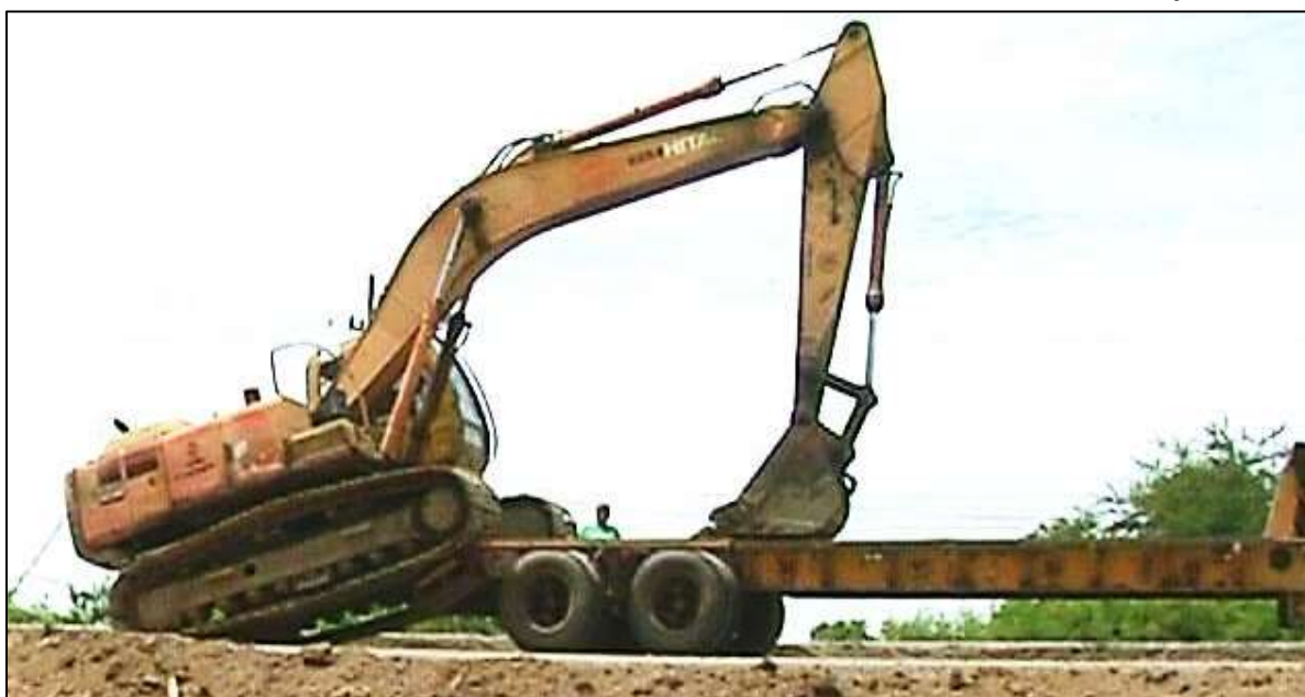
รูปที่ ๔-๕๐ การขึ้นลงรถบรรทุกเครื่องจักรกลของรถชุด
