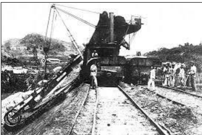
รูปที่ ๑-๓ รถขุดไฮดรอลิกในอดีต
