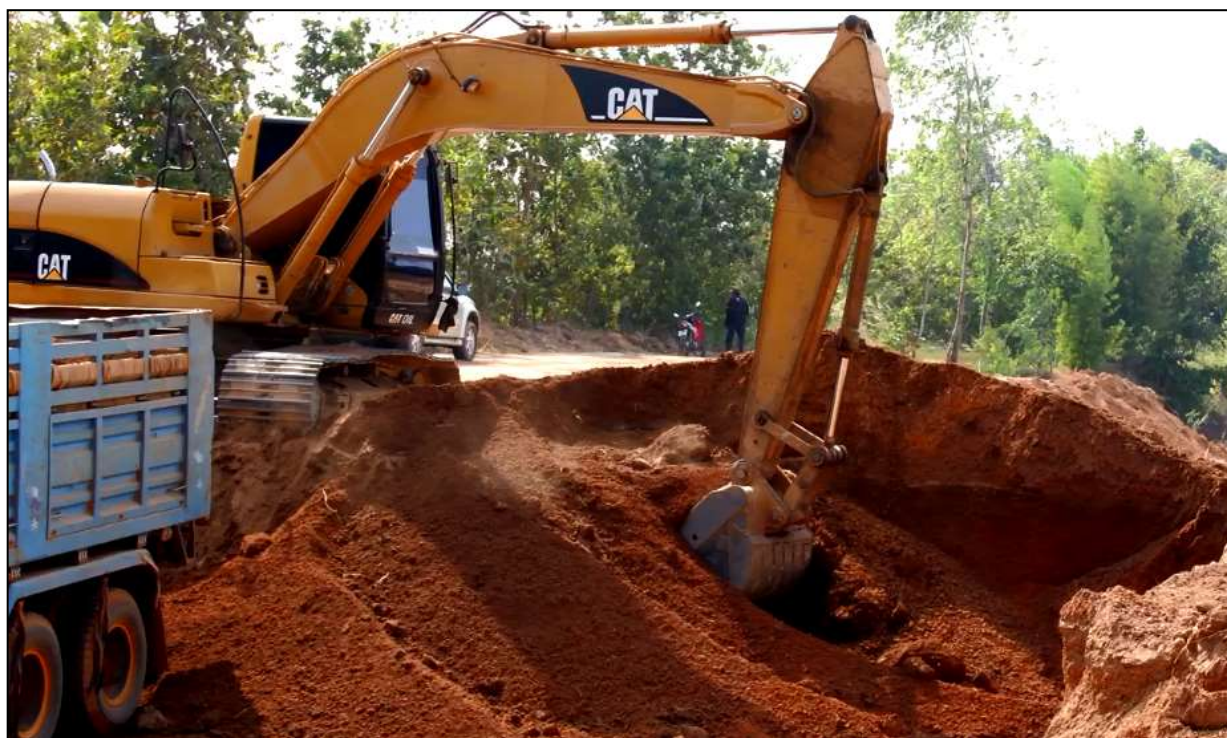
รูปที่ ๔-๒๗ การรวมกองวัสดุโดยใช้บั้งที่ด้านหน้า
