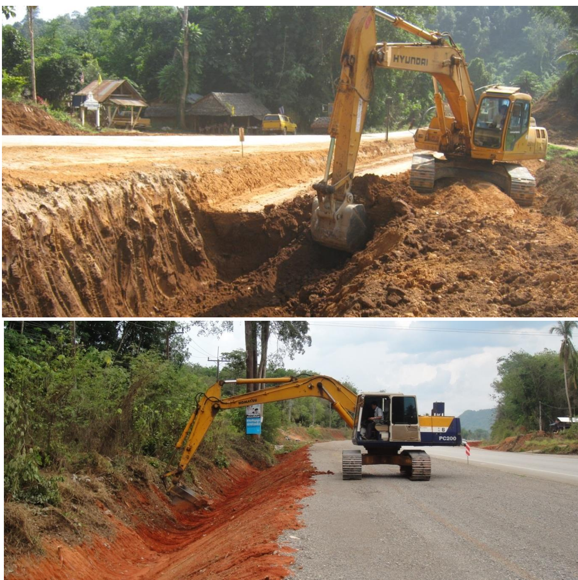
รูปที่ ๒-๓ การทำงานของรถขุดในงานขึ้นรูปคันทาง
