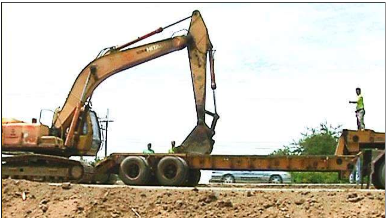
รูปที่ ๔-๔๘ การขึ้นลงรถบรรทุกเครื่องจักรกลของรถขุด
