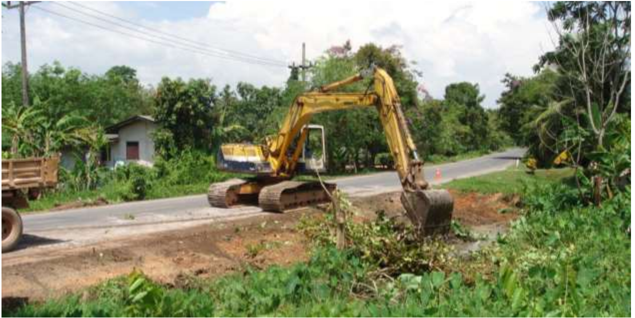
รูปที่ ๔-๒๙ การขุดแต่งร่องน้ำโดยใช้บั้งก็หลัง
