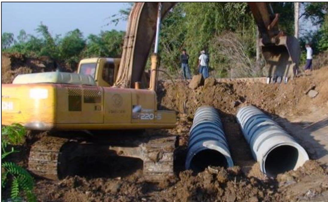
รูปที่ ๒-๑๑ การใช้รถขุดวางท่อในงานขุดวางท่อระบายน้ำ
