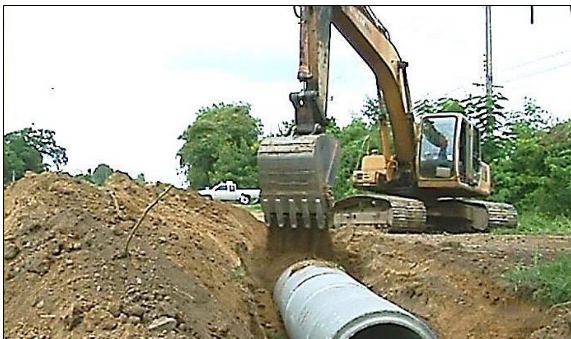
รูปที่ ๒-๑๒ การใช้รถขุดในการฝังกลบท่อระบายน้ำ
