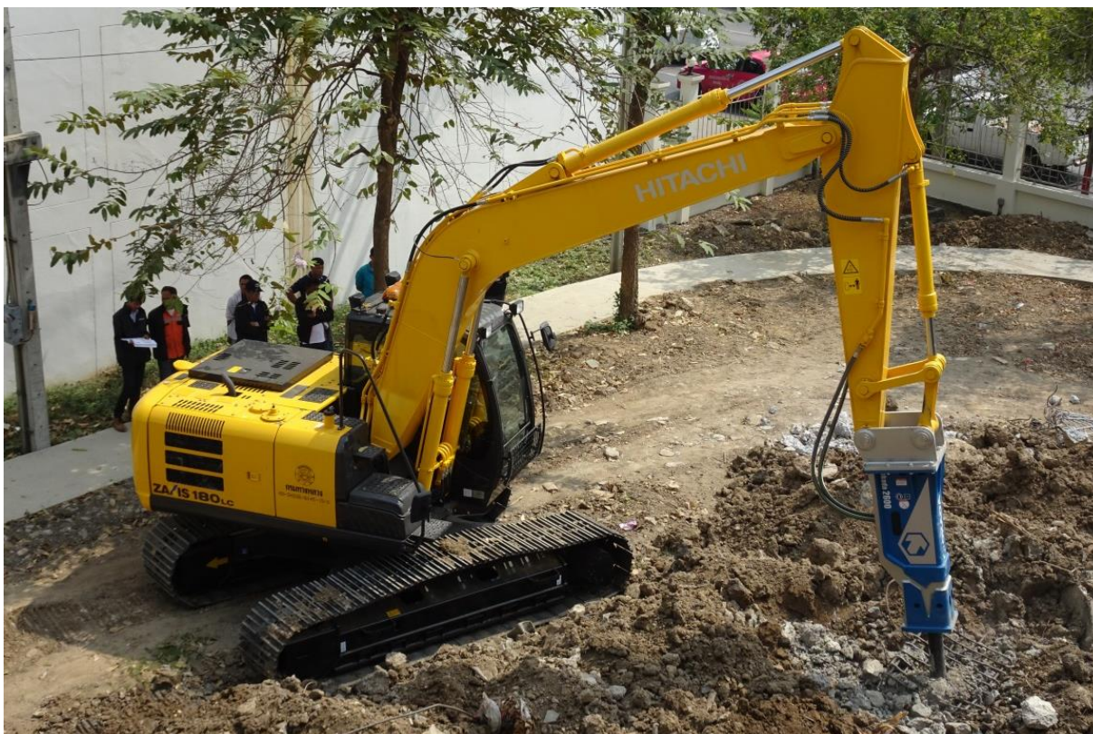
รูปที่ ๒.๑๖ การใช้รถขุดในการทุบรื้อโครงสร้างคอนกรีต
